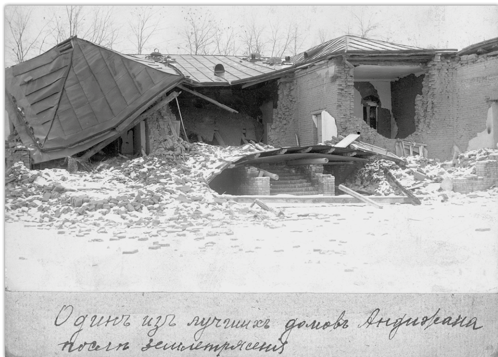
Рис. 7. Один из лучших домов Андижана (дом Дорофеевой) после землетрясения. Fig. 7. One of the best houses in Andijan (Ms. Dorofeyeva's house) after the earthquake.
