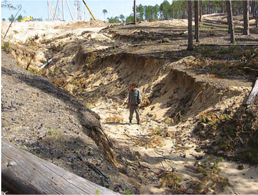
Thermoerosion along the ESPO pipeline / Термоэрозия по трассе «ВСТО»
