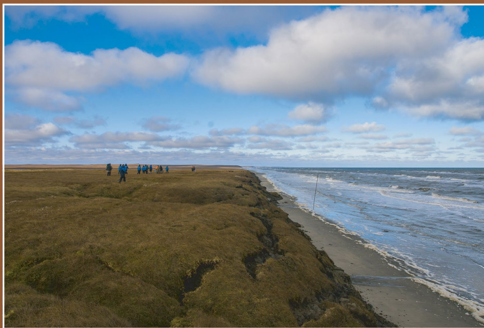
Солифлюкционное оползание талой породы по береговому уступу на западном побережье Байдарацкой губы Карского моря. Сентябрь 2015 г. Фото И.С. Соколова.
