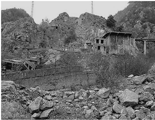
Рис. 5. Остатки верхней станции канатной дороги для транспортировки руды в Мизур. 2002 г.
