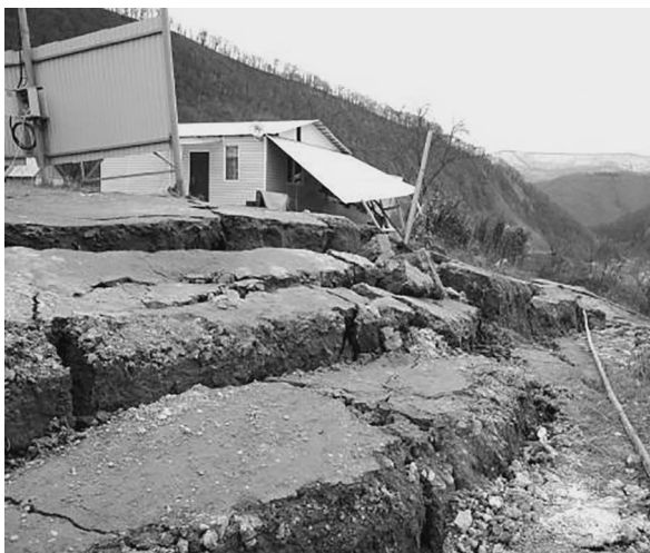
Рис. 3. Последствия активизации оползней в с. Барановка. Fig. 3. Consequences of the activation of landslides in the village of Baranovka.
