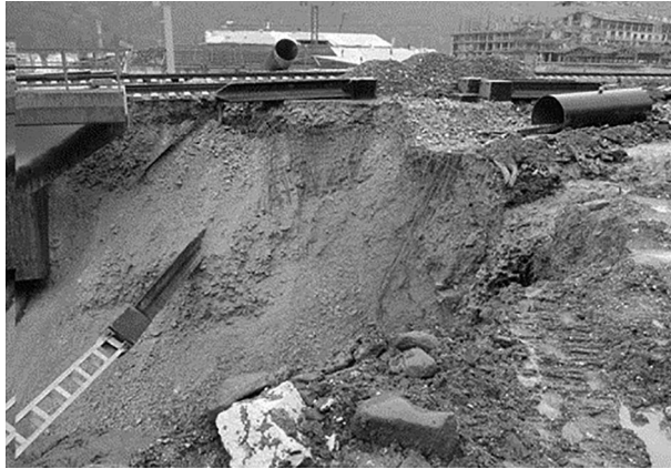
Рис. 4. Размыв насыпи ручьём Мостовой после селя 27.09.2013.
